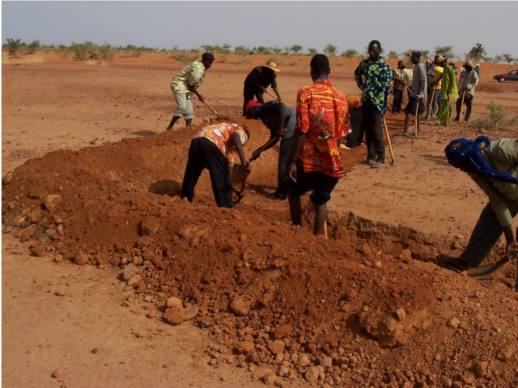
Document 4.14 – Construction d'une diguette au Niger septembre 2008 source CILSS
