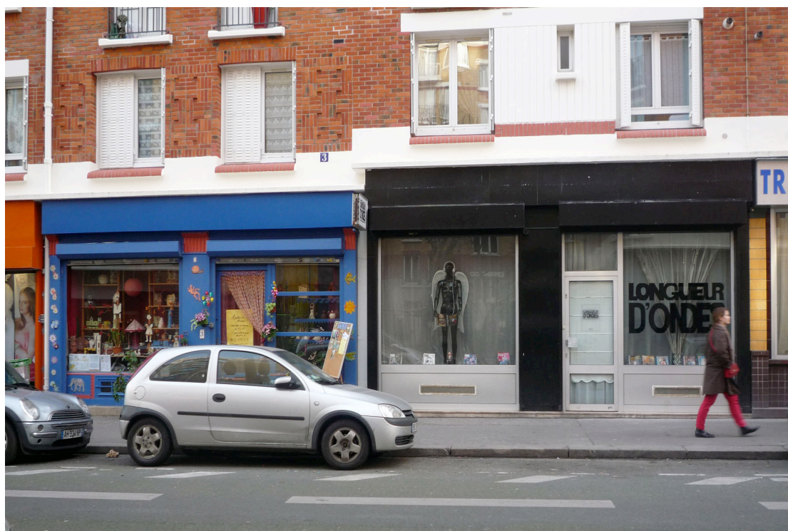
Figure 23 : L'une des rares « boutiques » dont la façade fait l'objet d'attentions esthétiques. Source : B. Lefèvre - 2015.
