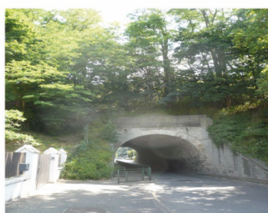
La Celle-Saint-Cloud (78) - Passage sous la voie ferrée
