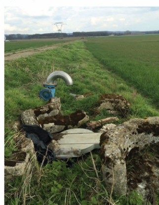
Photographie n°4 : Canalisations encore existantes du réseau des eaux usées (Morgane Flégeau, 2016)
