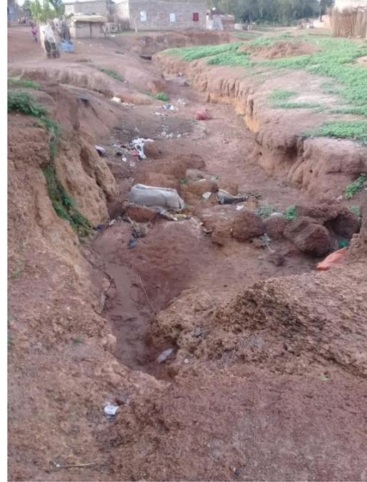
Figure 211 : Les dégâts des eaux de ruissellement sur les routes en latérite à Abattoir (Tambacounda). Clichés : Diouf, 2018.
