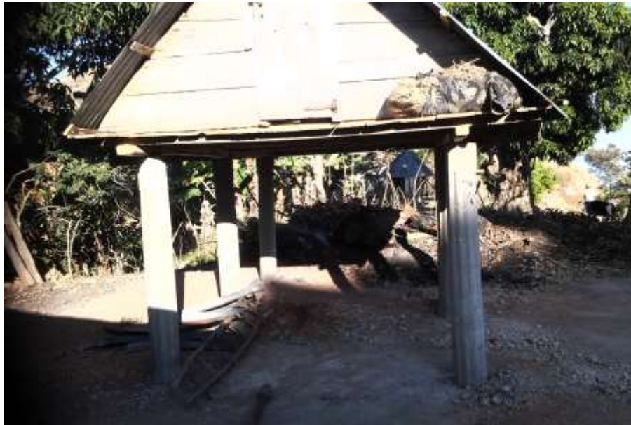
Figure 10: Colombier utilisé pour le stockage des en grain en milieu rural
