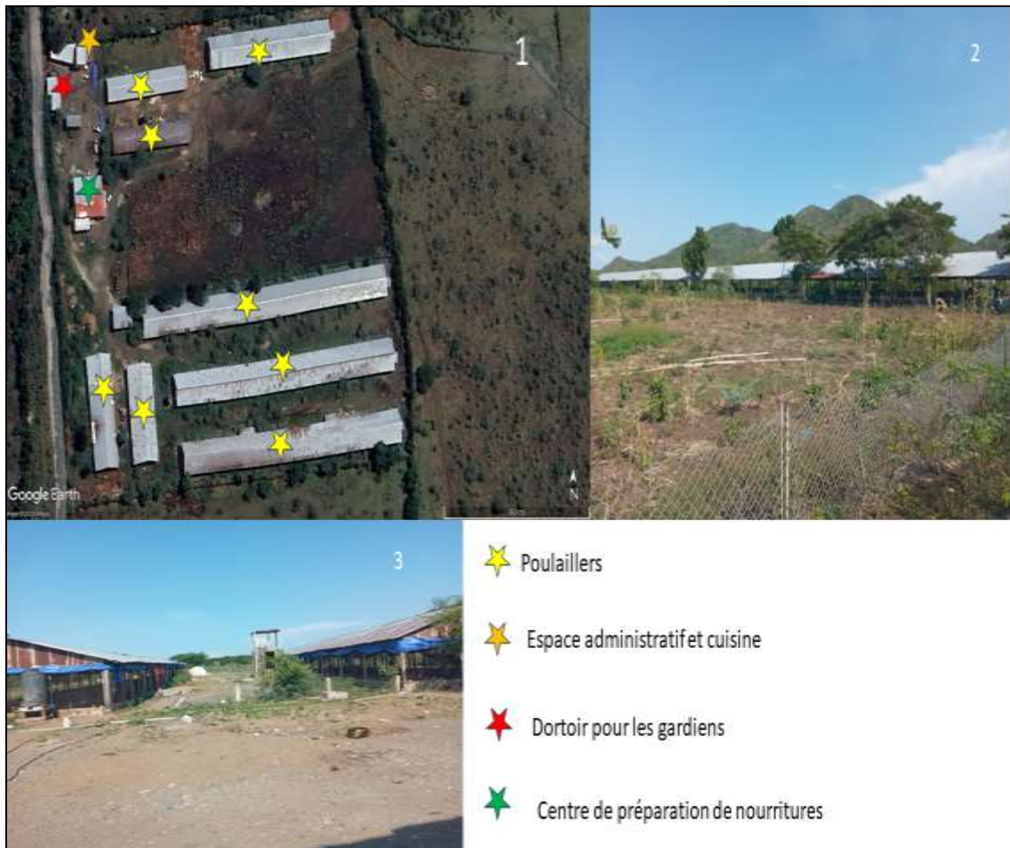
Figure 32 : Mode de construction des poulaillers dans le Nord et Nord-Est d’Haïti
