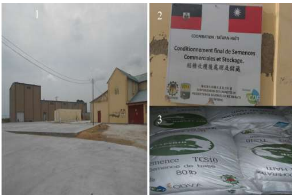
Figure 22 : Centre de stockage et de vente de semences produites par ODVA/MTT à Deseaux dans la commune de Dessalines
