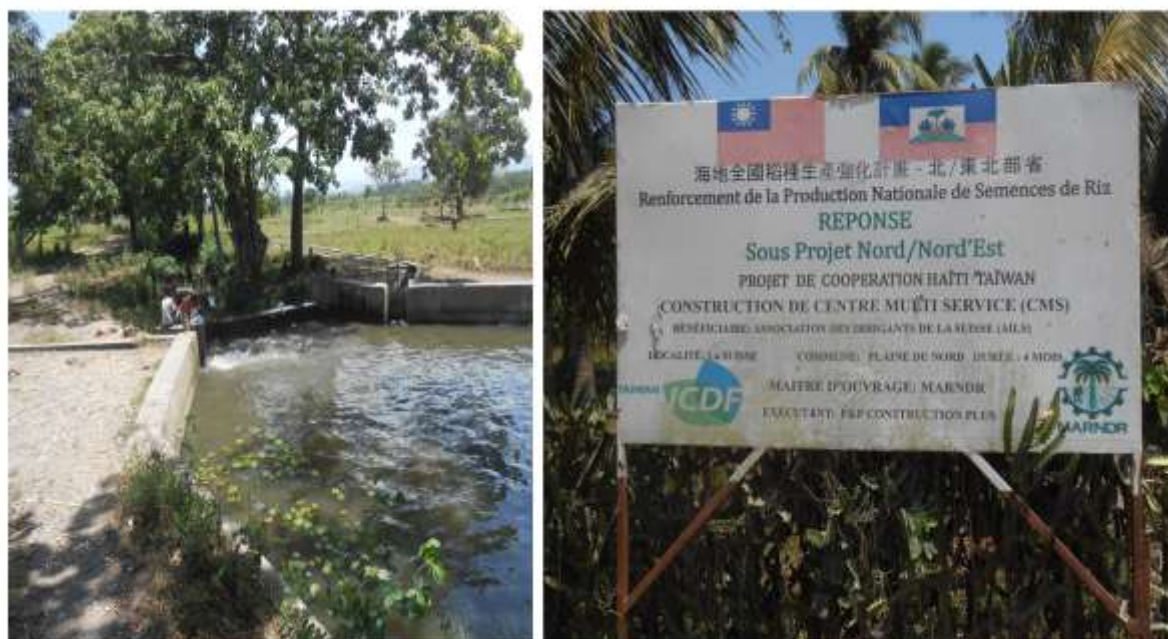
Figure 48 : Micro-Barrage de La Suisse et pancarte du projet de production de semence de la coopération taïwanaise.
