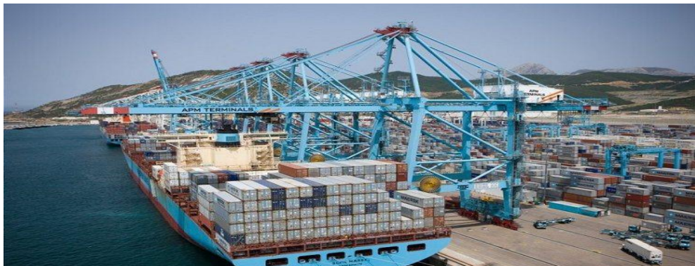
Figure 16 : Grue à quai
