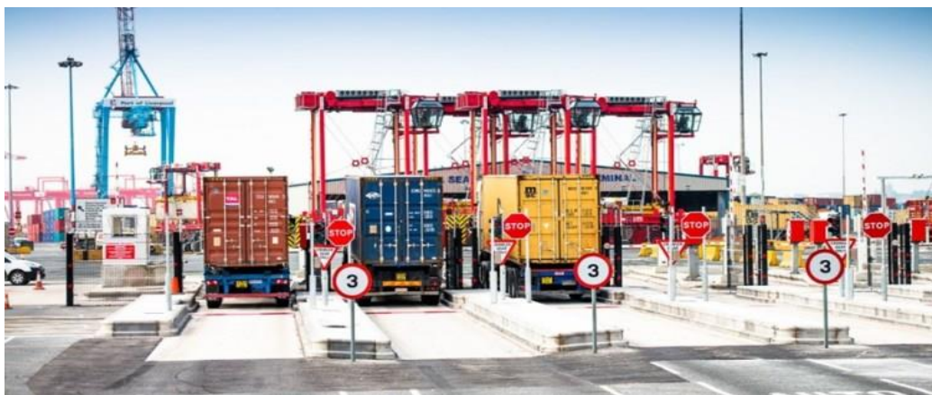
Figure 15 : Guérite d'un terminal à conteneurs
