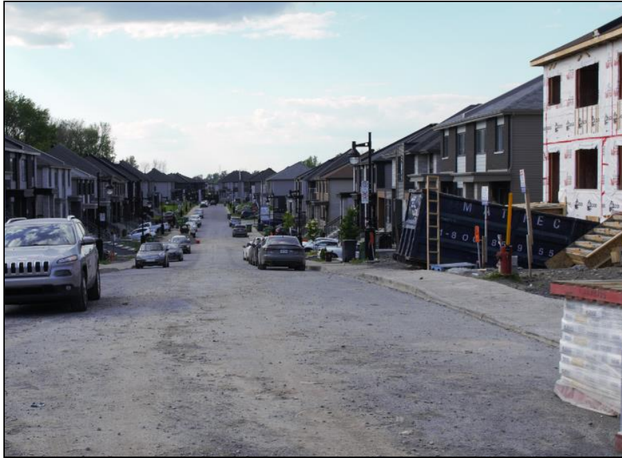
Figure 169 : Lotissement en construction dans le nouveau faubourg (Rue Trefflé-Berthiaume)
