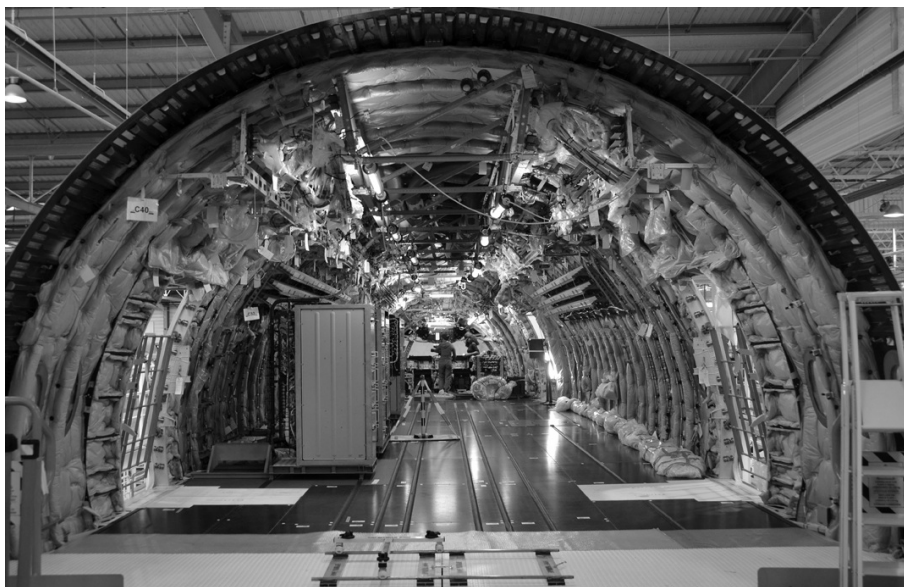
FIGURE 1.1 – Exemple de fuselage en cours de construction
